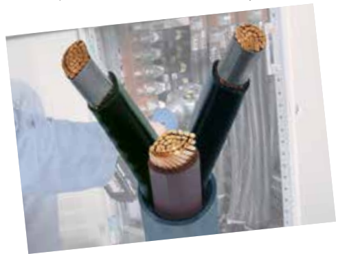
Опрессовка втулок для секторных жил в три этапа
